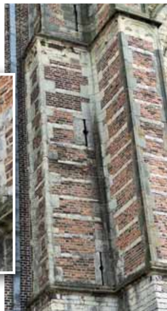
Afb. 6 Drie van de vier schietgaten in de toren van de Grote Bartholomeuskerk, eerste geleding, west, ca. 1375; inzet, detail. Foto's RKa, 2025.
