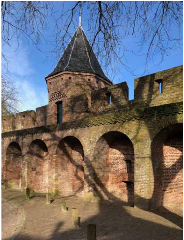
9. Stadsmuur met poort in Amersfoort met de bogen
