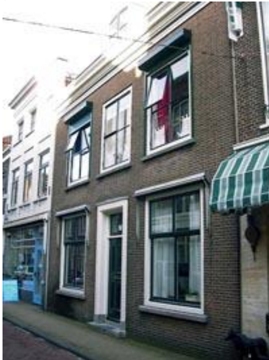
Toenmalige woning van de familie Graves Kooiman, thans Koestraat 73. Achter het pand staat de voormalige werkplaats.
