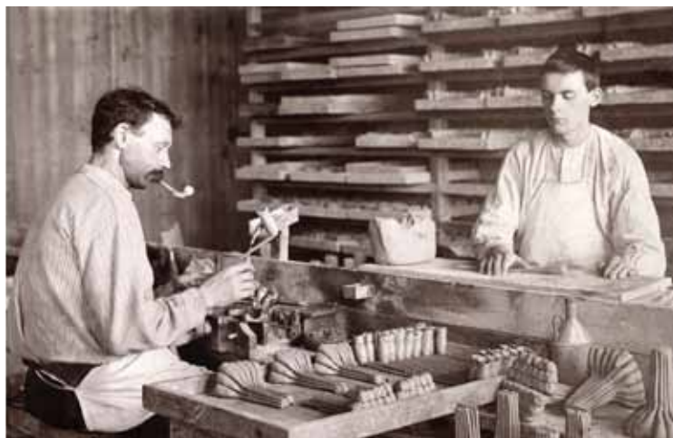
Rechts is een rolder te zien, die de grondvorm van de pijp rolt. Links de kaster die een pijp uit de persvorm haalt. Op de voorgrond bundeltjes net gemaakte pijpen, ca. 1913
