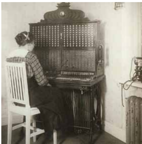
Centrale met zogenaamde plugaansluitingen
