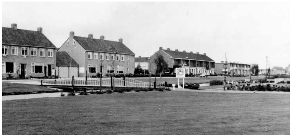
Carillonstraat gezien vanuit het Vredenburg-Park
