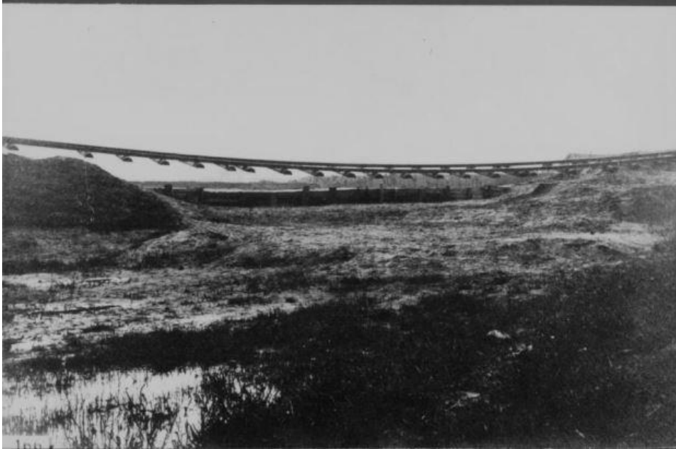
Deze foto zou genomen zijn in 1911 en een beeld geven van de verzakte spoorlijn bij Goejanverwellesluis.
