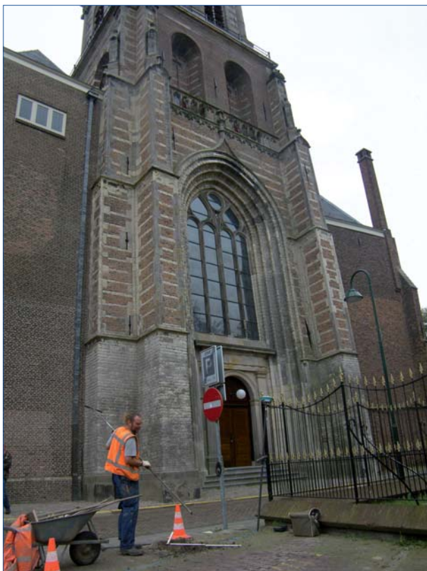
Figuur 6. Impressie van het uitvoeren van de boringen: Jeroen van Eijk zet één van de boringen op locatie 13 (kruising Kerkstraat/Koestraat).
