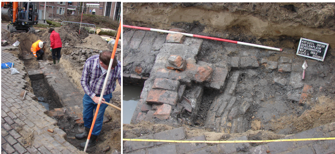
Afb.2 : links het vrijleggen van de stadsmuur in WP2 segm. 2 en rechts het oostelijke gelegen riool.
