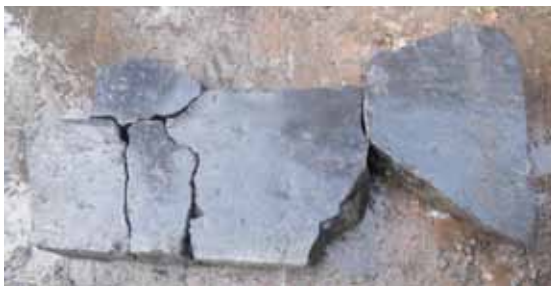
Vijf brokken natuursteen ter stutting van de paalfundering
