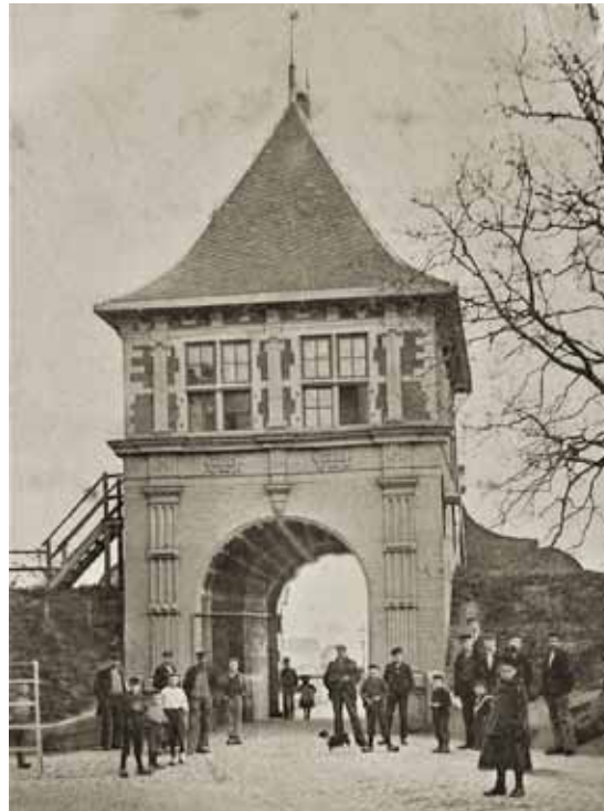
Die houten trap opzij van de Veerpoort werd bij de restauratie in 1918-1920 vervangen door de huidige trap.
